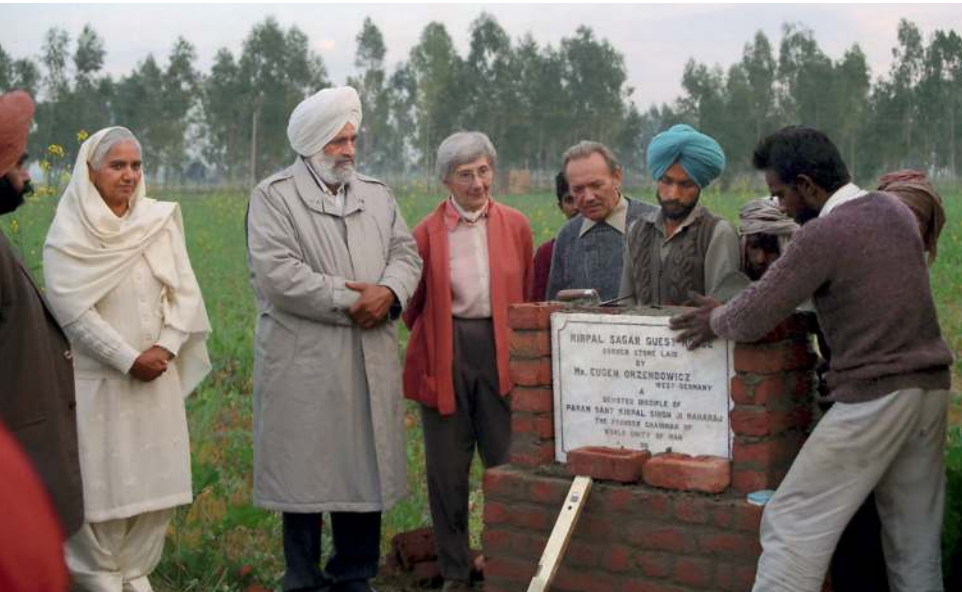
Oben links: Grundsteinlegung für das Gästehaus
